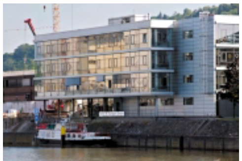
Gebäude der Hafen Stuttgart GmbH (Foto: Zell)
